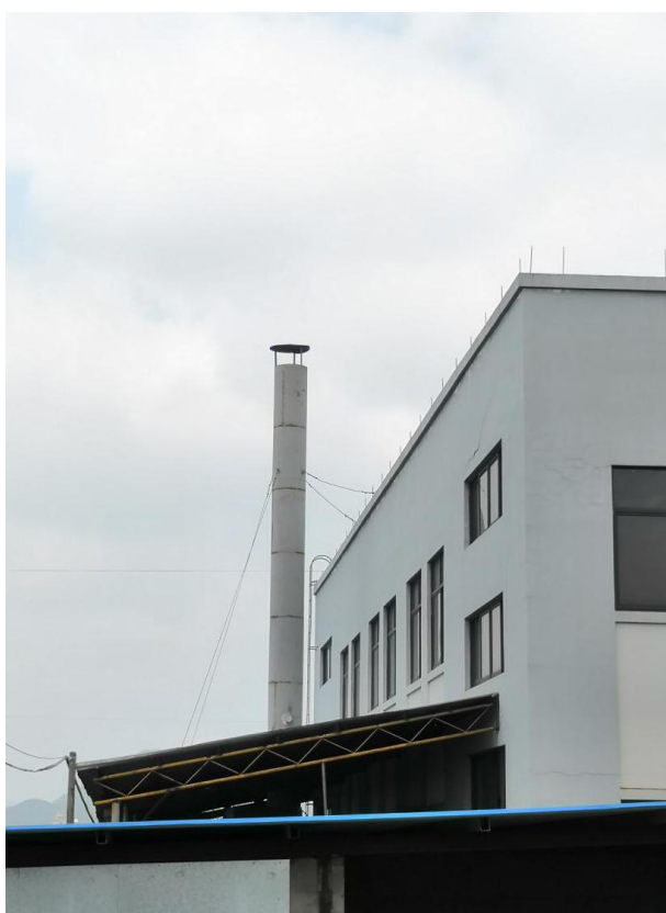
活性炭吸附-脱附催化燃烧设施及其排气筒
